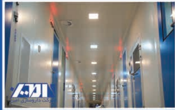
انجام پروژه های اتاق تمیز به صورت EPC (طراحی، ساخت تجهیزات و اجرا)
